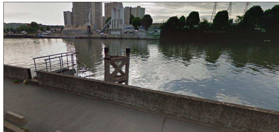
Duc d'Albe au niveau de la friche Arrighi (Source : Google Maps)
